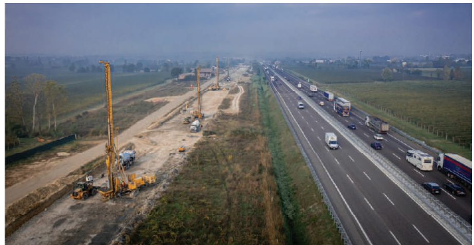
12. Realizacja kolumn wibrowymiany [4]
