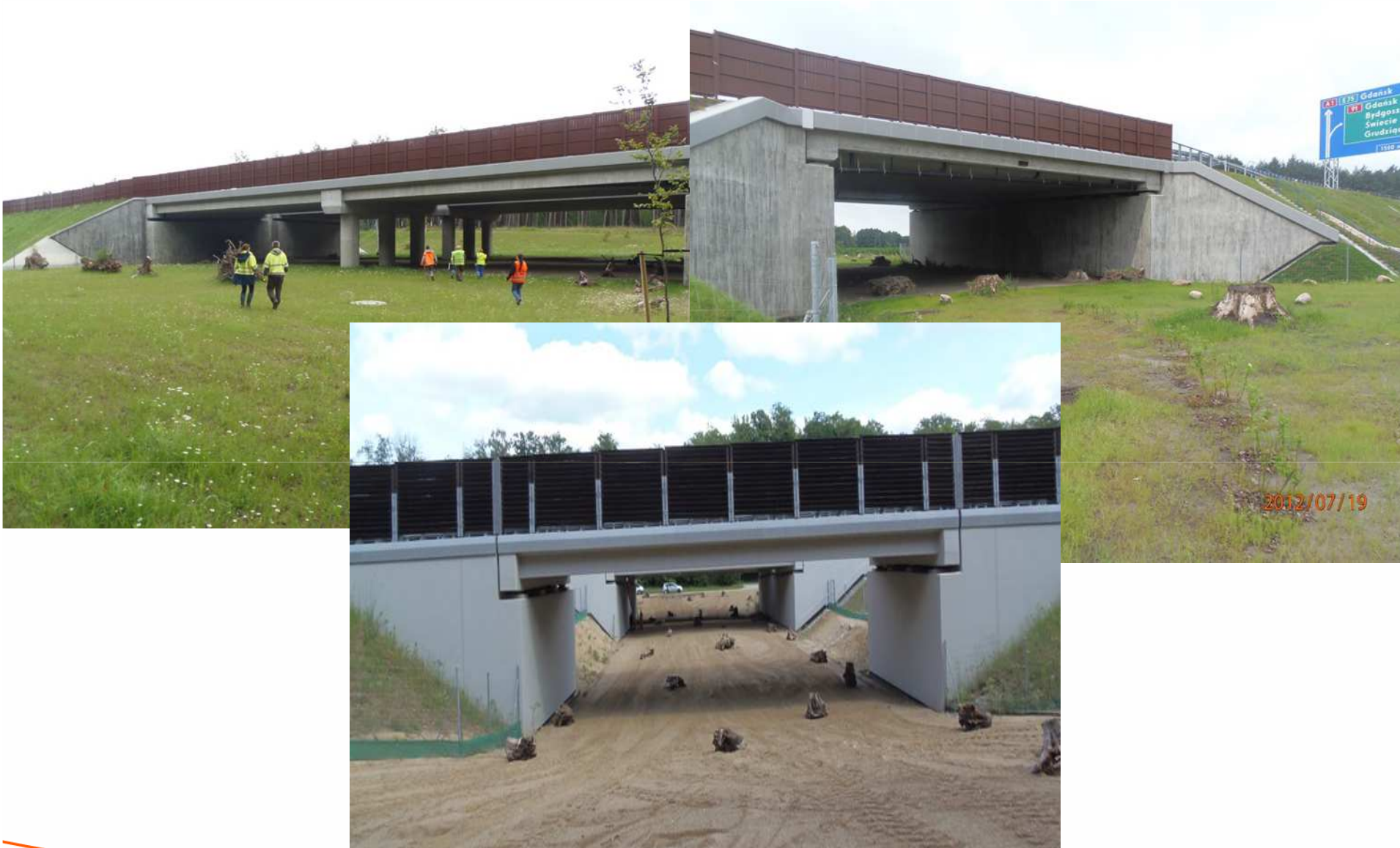
Przejścia dolne dla zwierząt na drogach krajowych
