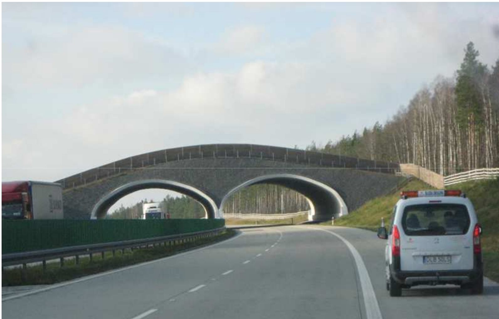
Przejście górne dla zwierząt na autostradzie A4, odcinek Zgorzelec - Krzyżowa
