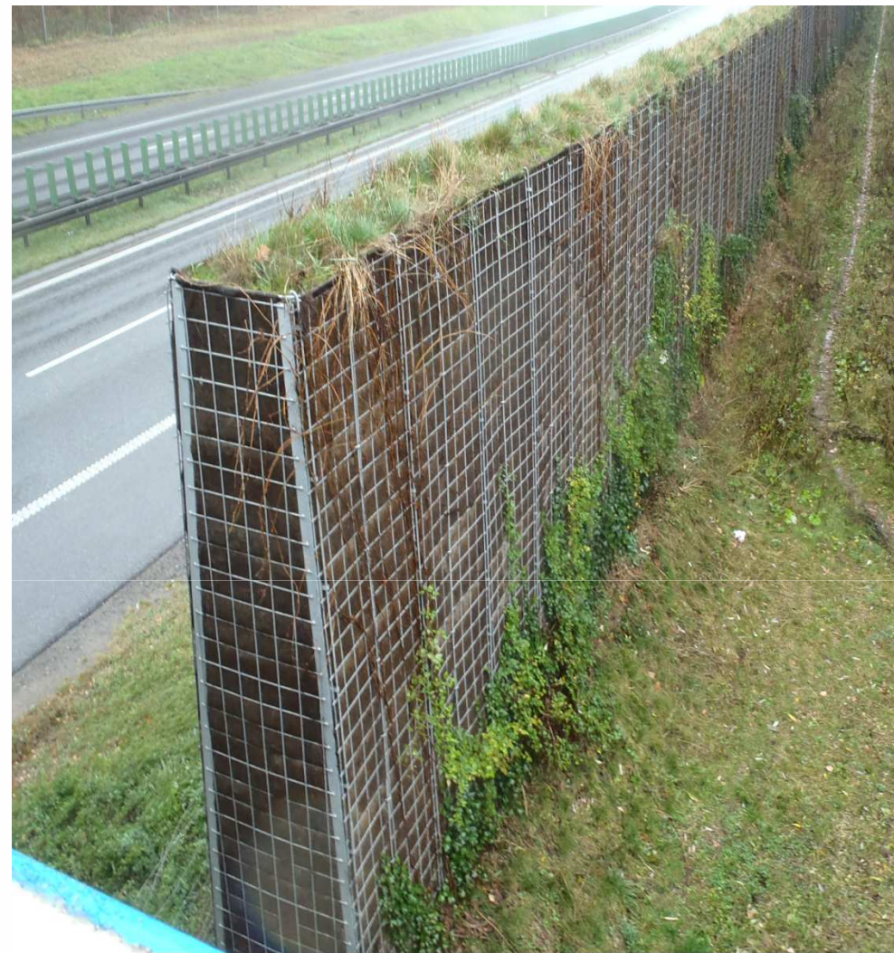
Bariera dźwiękochłonna na stelażu stalowym z wypełnieniem ziemnym na małopolskim odcinku autostrady A4
