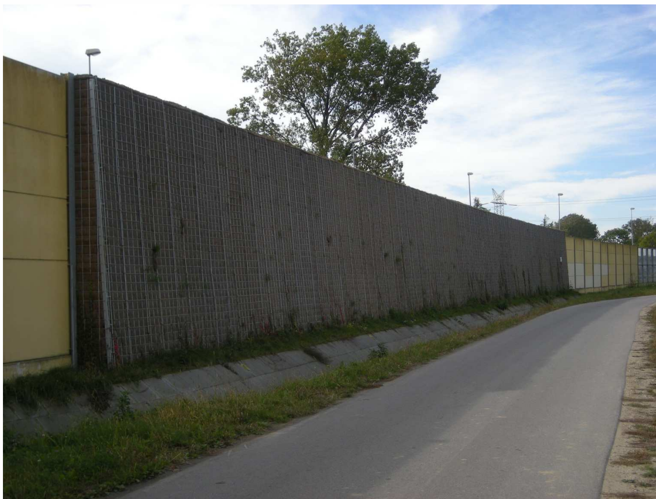
Fragment bariery dźwiękochłonnej na stelażu stalowym z wypełnieniem ziemnym na obwodnicy Wojnicza w ciągu drogi krajowej nr 4
