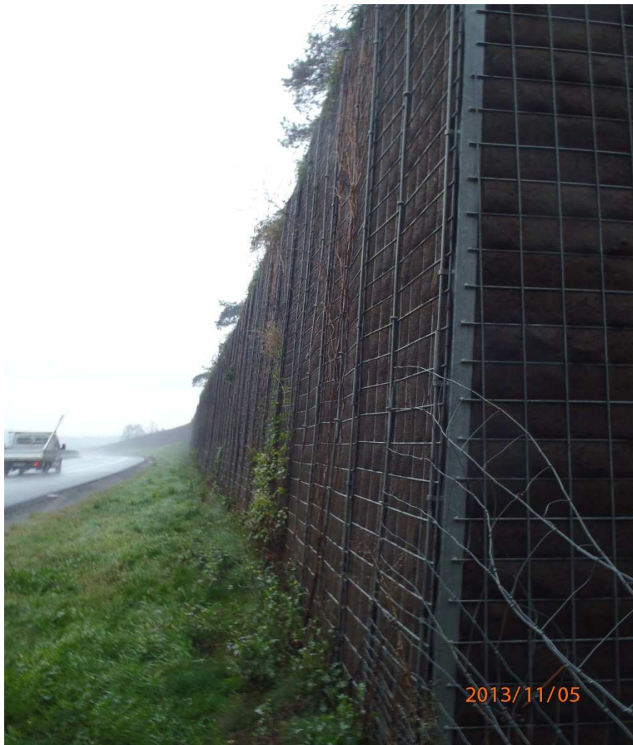
Bariera dźwiękochłonna na stelażu stalowym z wypełnieniem ziemnym na małopolskim odcinku autostrady A4
