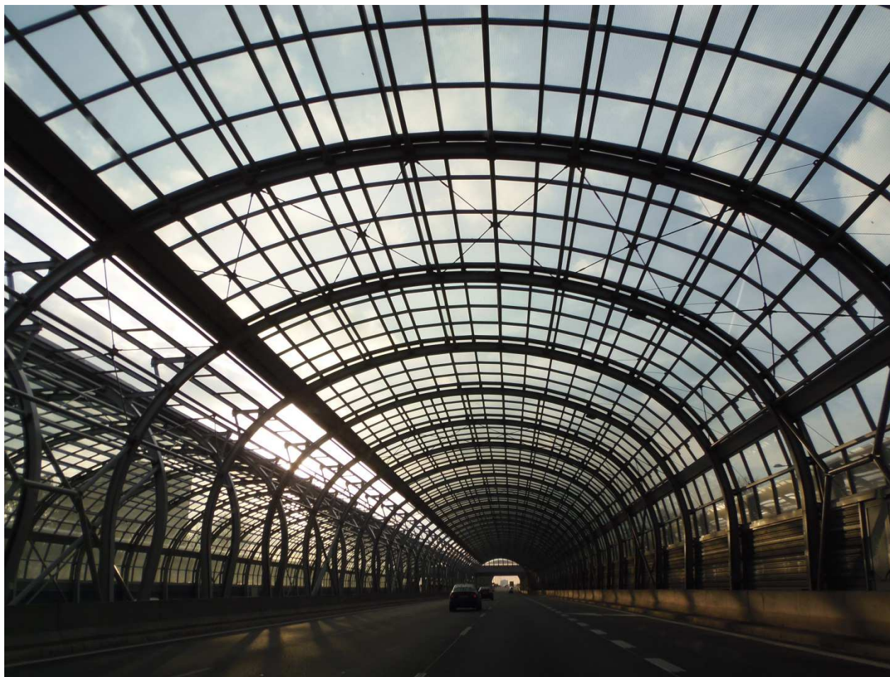
Nowoczesny ekran tunelowy na odcinku drogi krajowej nr 8 w Warszawie („Trasa Toruńska” – Bródno)
