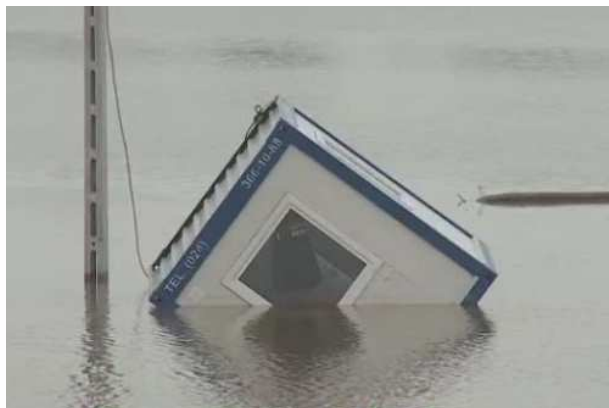
Zalany plac budowy autostrady A1
