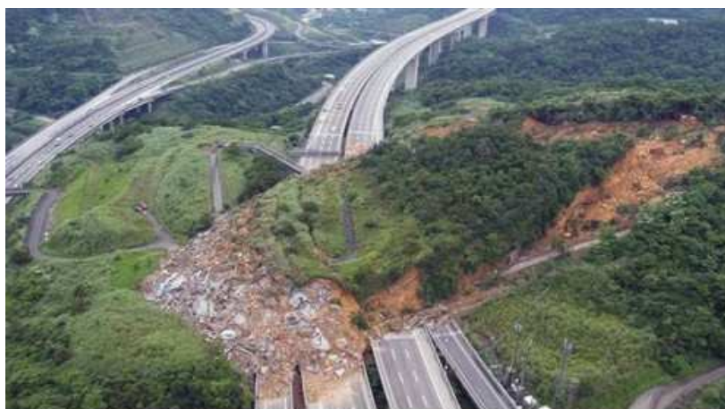
Osuwisko o długości ok. 300 m (Tajwan)
