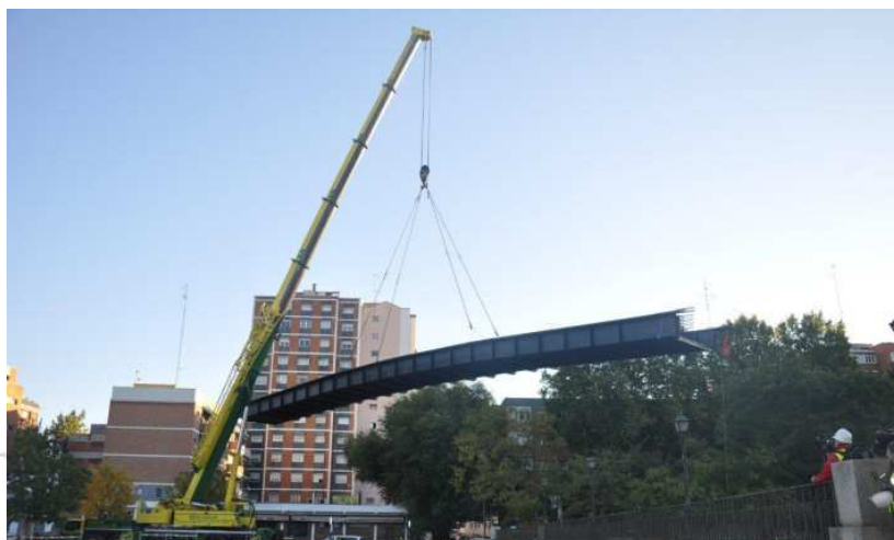
Montaż na budowie
