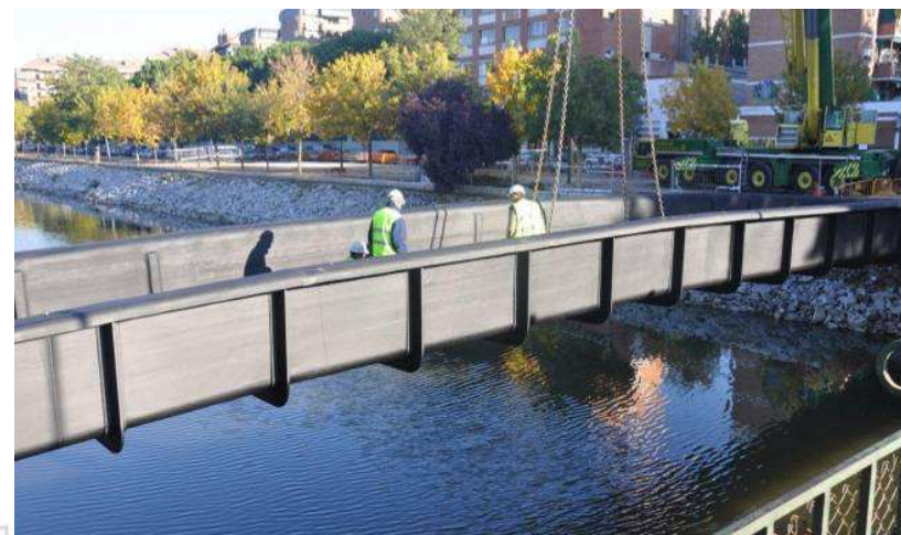
Montaż dźwigara na budowie
