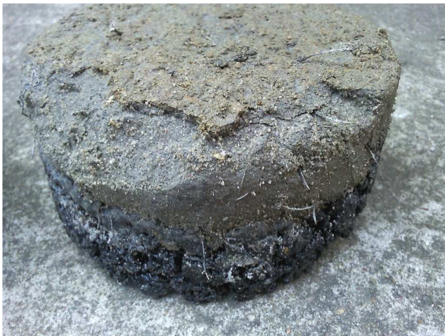
ZDJĘCIE 12 - POŁĄCZENIE MMA Z MATĄ WYPEŁNIONĄ ZAPRAWĄ CEMENTOWĄ
